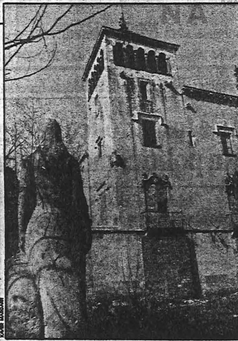
La finca se ha visto profundamente degradada durante los últimos años
